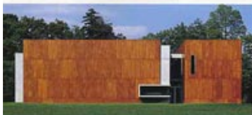
Vues extérieures du bâtiment du Frac, architecte Jean-Claude Pondevie © Frac des Pays de la Loire
